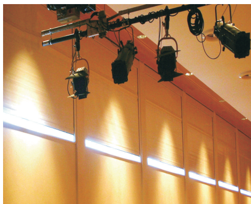
Mehrzweckhalle, Zavelstein (FixTex - Totalverdunkelung)
