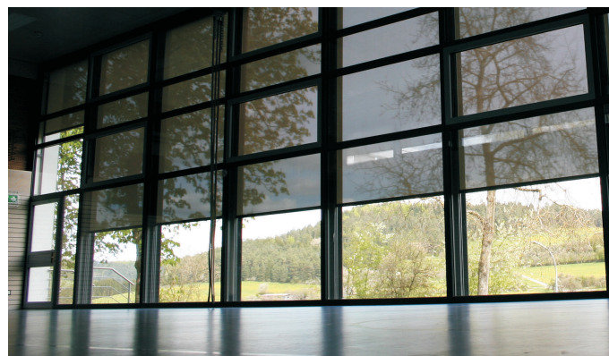
Halle, Haiterbach (FixTex - Beschattung Breite:2,10 Höhe:5,30m)
