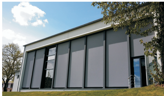
Halle, Haiterbach (FixTex - Beschattung Breite:2,10 Höhe:5,30m)
